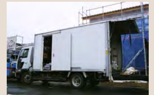
吹付け断熱工事の専用車両。発電機や材料が積まれています。
