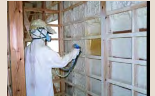
吹付け作業の様子。完全防護で作業にあたります。
